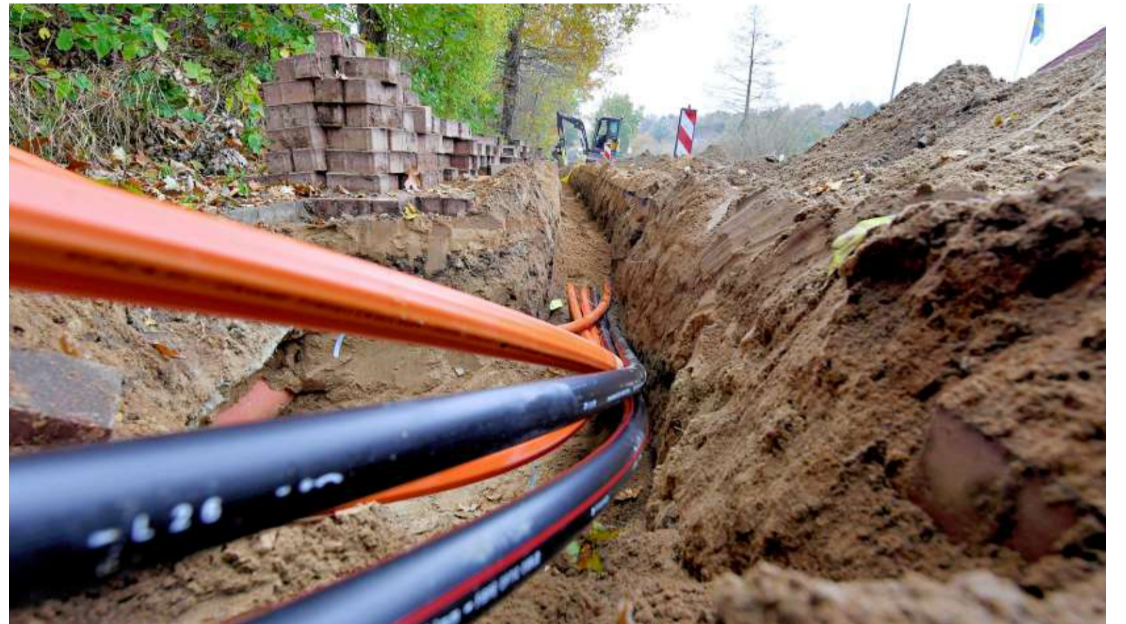
Glasfaserkabel wie diese in Schleswig-Holstein sollen ab dem Frühjahr, innerhalb von acht Monaten Bauzeit, auch in Stecklenberg in die Erde kommen. FOTO: DPA
